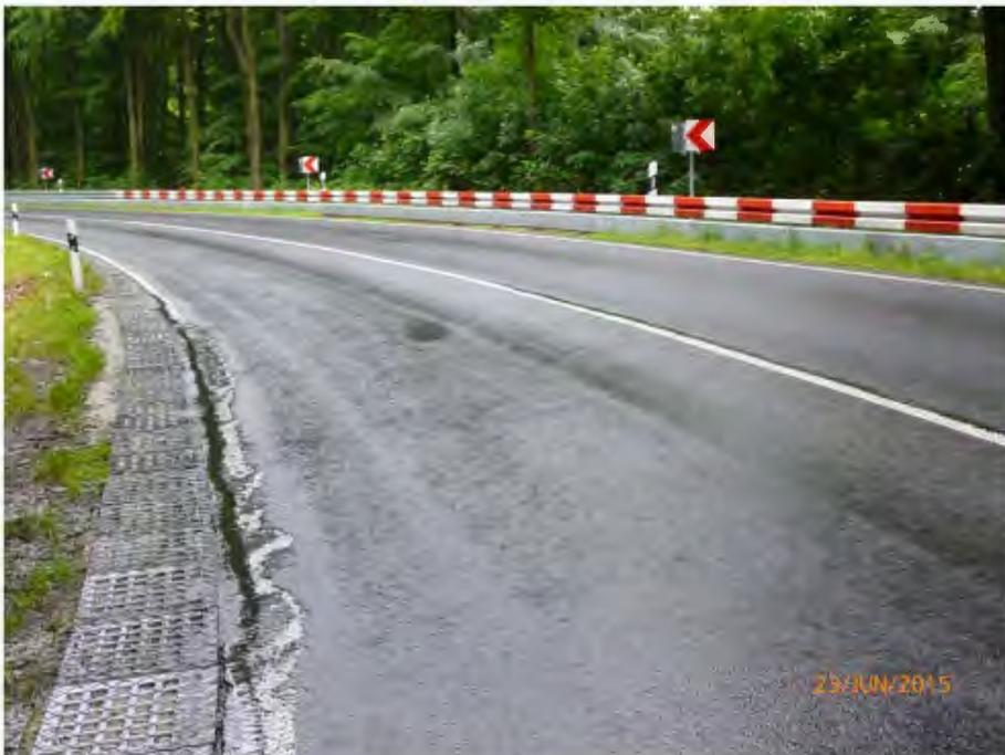
Bild 4: Bitumenverguss am Fahrbahnrand
