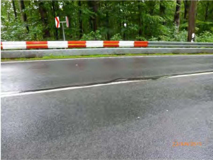
Bild 3: Bitumenverguss in der Fahrbahnmitte
